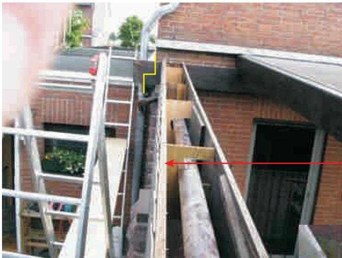
Die Verkleidung mit innenliegendem Regenrohr wurde um ca. 2 cm verschoben.
