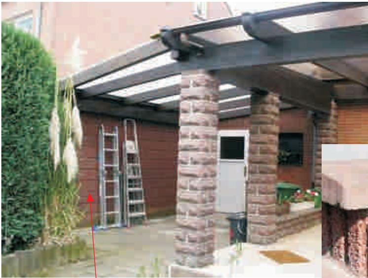
Die Querpfette und die Pfosten wurden mit dem Mauerwerk verschraubt.
